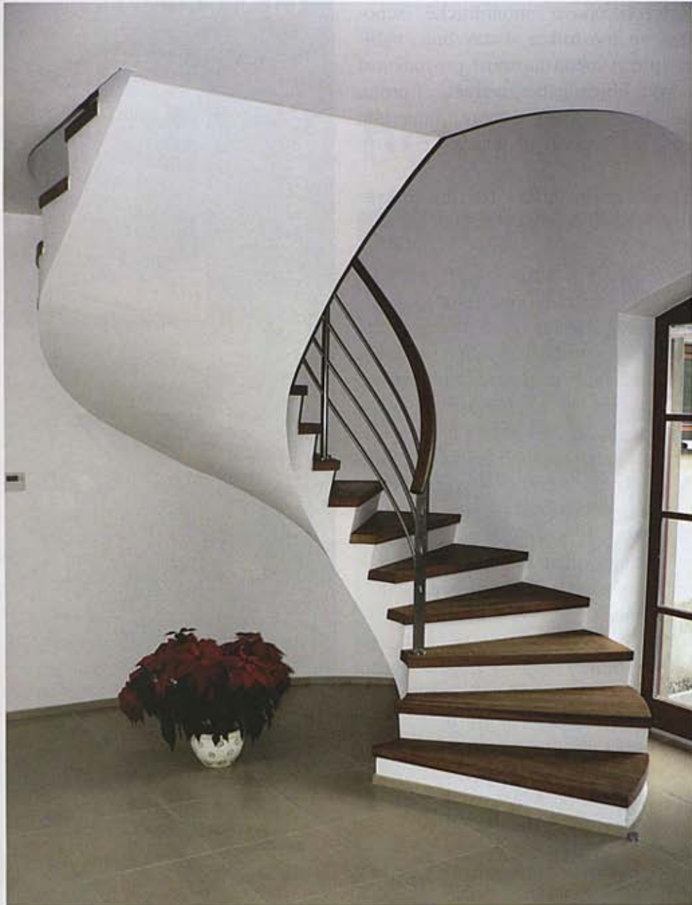
Interiérové spirálovitě točité monolitické schodiště z betonu na plné desce s dřevěným obkladem.
